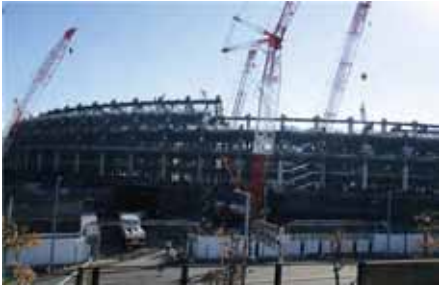
東京体育館側から見た建設現場
