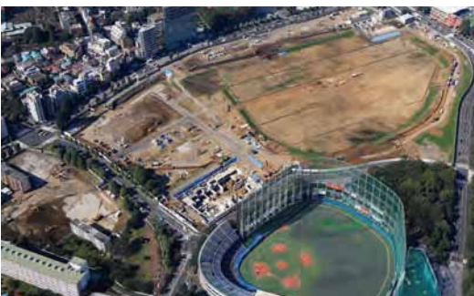
解体直後の国立競技場
